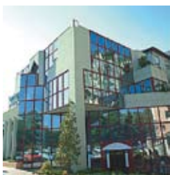
Управление на отоплението и вентилацията в сгради
